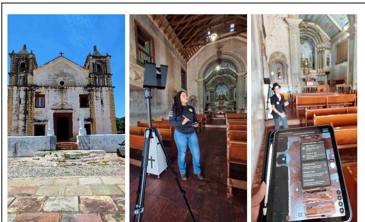
Legenda: Levantamento arquitetônico da edificação através de escaneamento a laser. Autoria: Francielle Ferreira Data: 29/02/2024
